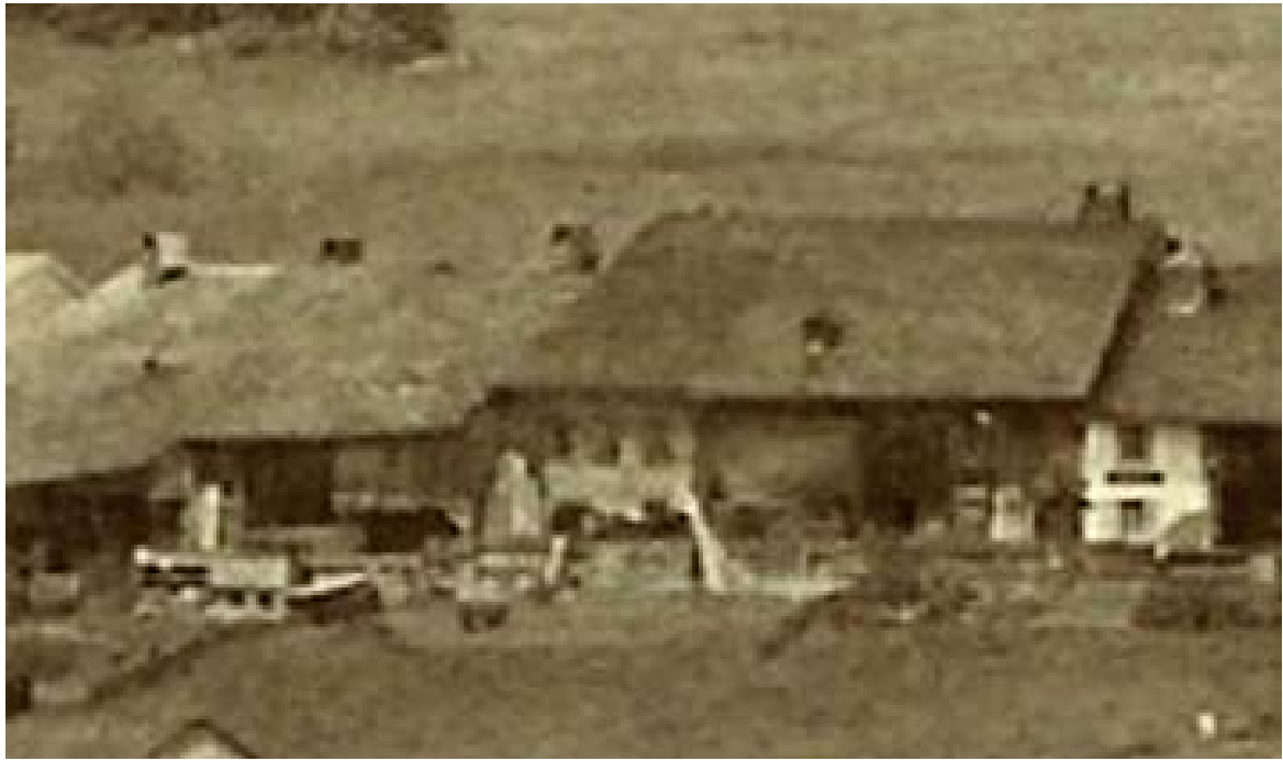
Maison avec la porte voûtée, ancienne école des Charbonnières. La salle était à l'étage, derrière les trois fenêtres.
